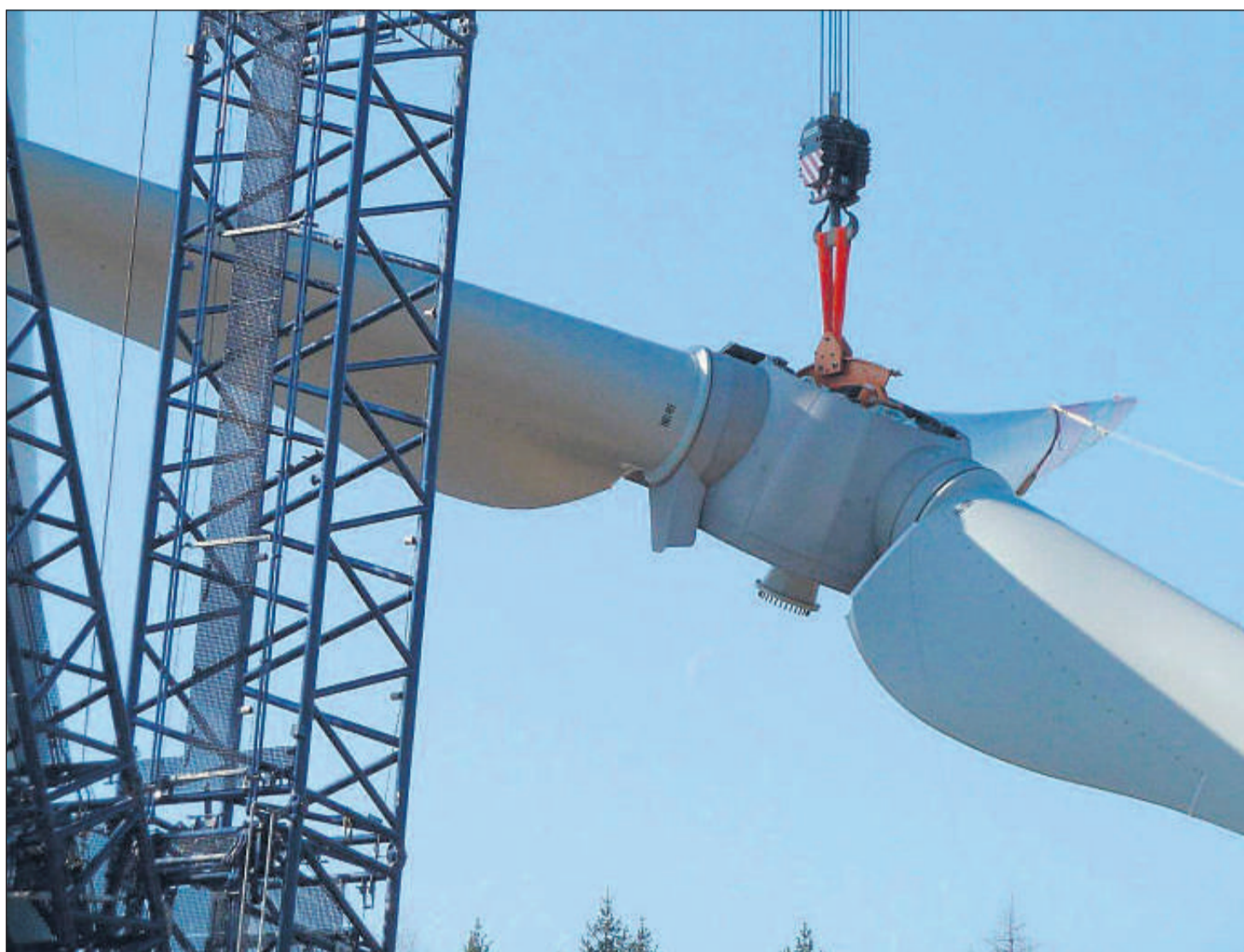
Der Rotor am Haken: Im März 2012 wurden die Windräder im Dürrheimer Wald montiert. Der Rotor wiegt etwa 50 Tonnen.
